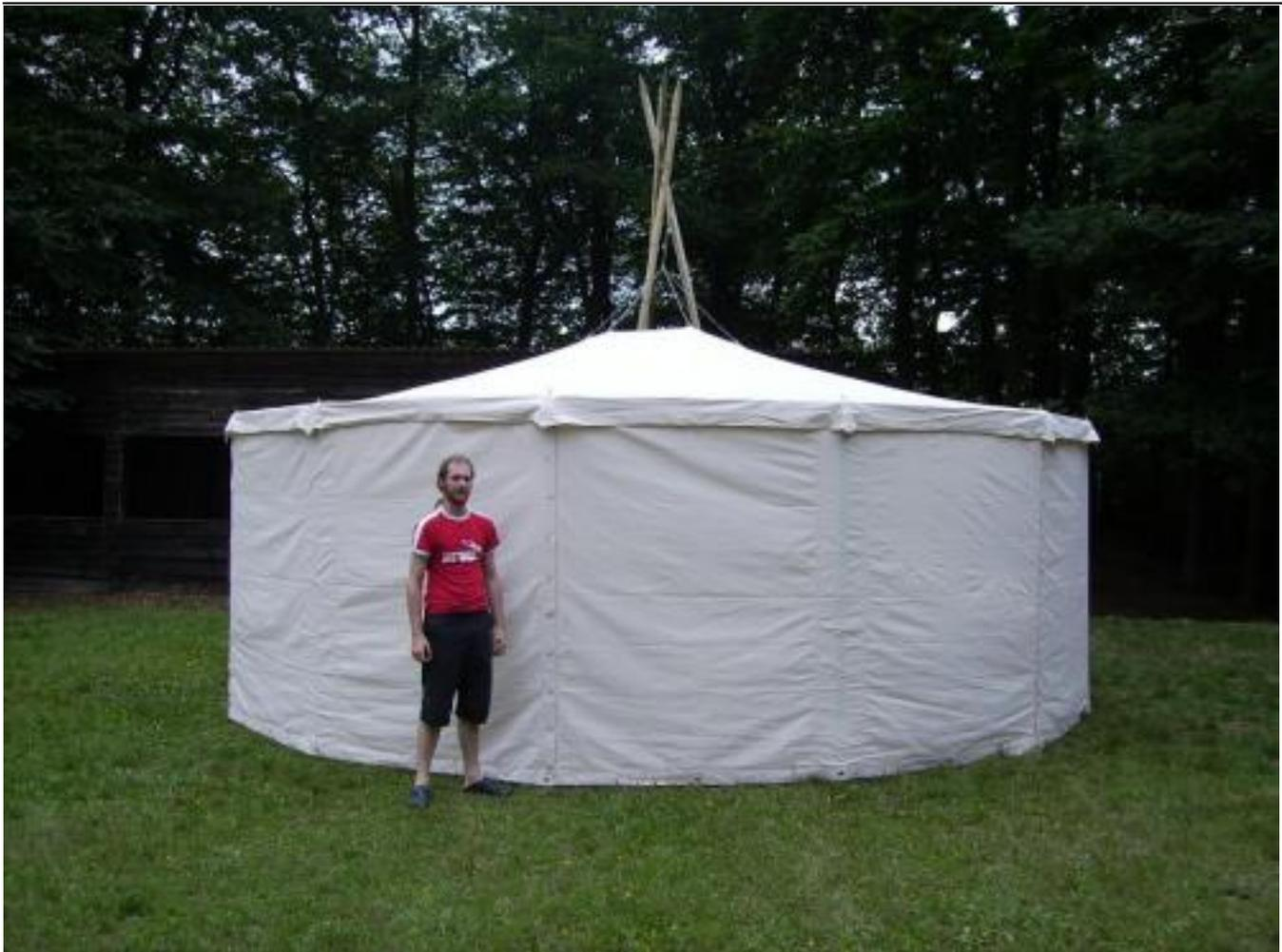
Der vorerst letzte Schritt ist das Einknüpfen der Seitenbahnen. Damit ist die Jurte geschlossen und steht ordentlich auf festem Boden. Du kannst die Seitenwände auch unten an den Winkeln abspannen, um das ganze noch etwas zu straffen.
