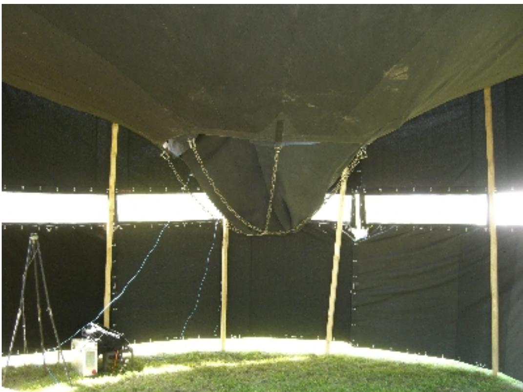
Am Mittelmast haben wir Zwei Seilrollen montiert: Eine für das Dach und eine für das Kondom. P.s. die Umlenkrollen müssen bei 2 Seiten und einer Fensterbahn (3,6m Seitenhöhe) bei 7m sein. wenn es weniger ist, bekommt ihr das Dach nicht richtig gespannt und das Kondom nicht hoch genug!!!
