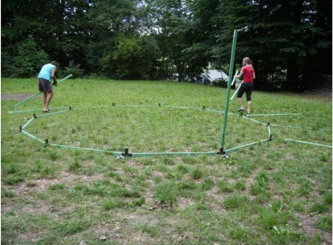
Du beginnst mit dem unteren Ring. Die richtigen Winkel sind jene, die unten flach sind und bei denen ein kleiner Winkel mit Loch nach oben zeigt. Die oberen Winkel sind die mit der Schraube als Spitze.
