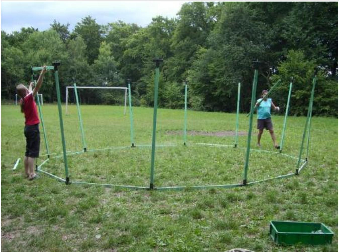
Es folgen die senkrechten Latten des Jurtengerüst. Die Länge dieser Latten ist abhängig davon, wie du deine Jurte aufstellst. Hast du hohe Seitenwände oder die Normalen? Soll der Stoff unten auf dem Boden möglichst abdichten, oder noch ein wenig Luft in die Jurte lassen? 10 cm weniger als die Höher der Seitenplanen sind ein gutes Maß. Details findest du in den unten angehängten Beschreibungen.
