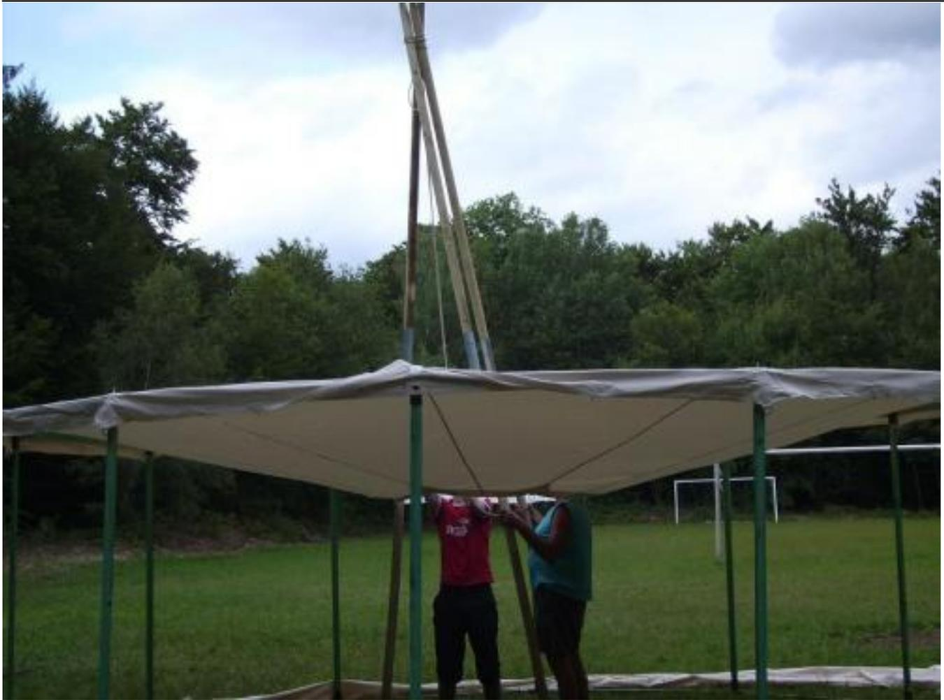
Wie beim normalen aufbau mit Heringen und Seile kannst du nun die Mittelstangen einsetzen und das Dach nach oben ziehen. Ob du dabei eine, zwei oder drei Mittelstangen verwendest bleibt deinen Vorlieben und Erfordernissen überlassen.
