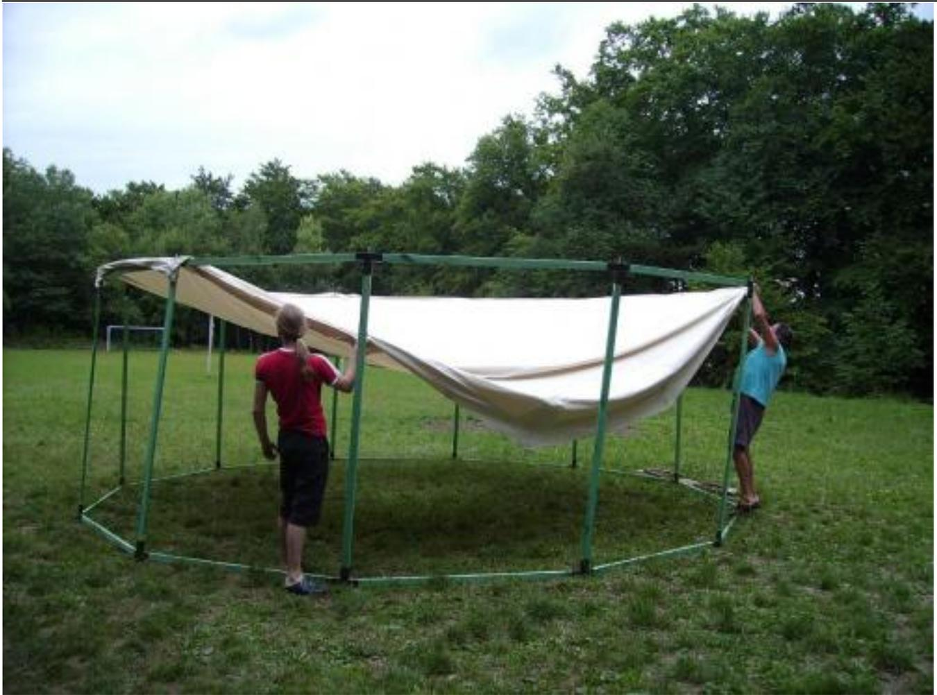
Als nächstes kannst du das Dach einhängen. Bei der hohen Variante solltest du aufpassen, dass die Ösen sauber über den Schrauben der oberen Winkel sitzen. Wer hier zu eilig vorgeht kann leicht den Stoff des Daches verletzen.
